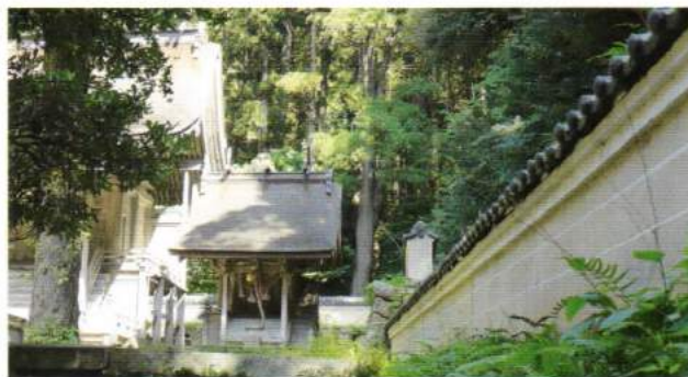
齋宮神社本殿 壁面には二本の定規筋があります
