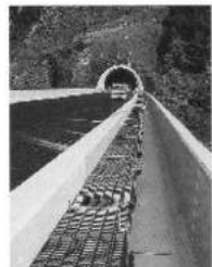
橋梁部での多条添架
