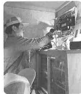
訪問先で漏電検査
