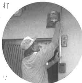
漏えい電流計にて漏えい電流（絶縁測定）の測定
