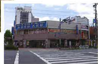
阪急西院駅 旧駅舎
