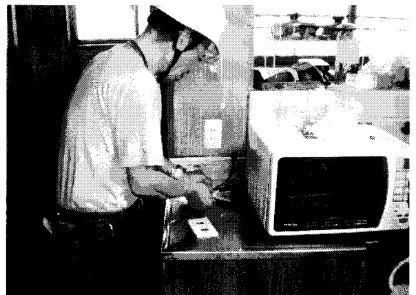
念入りに点検、その場で手際よく改修
