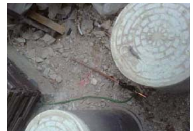
外構工事時に接地線が外れた
